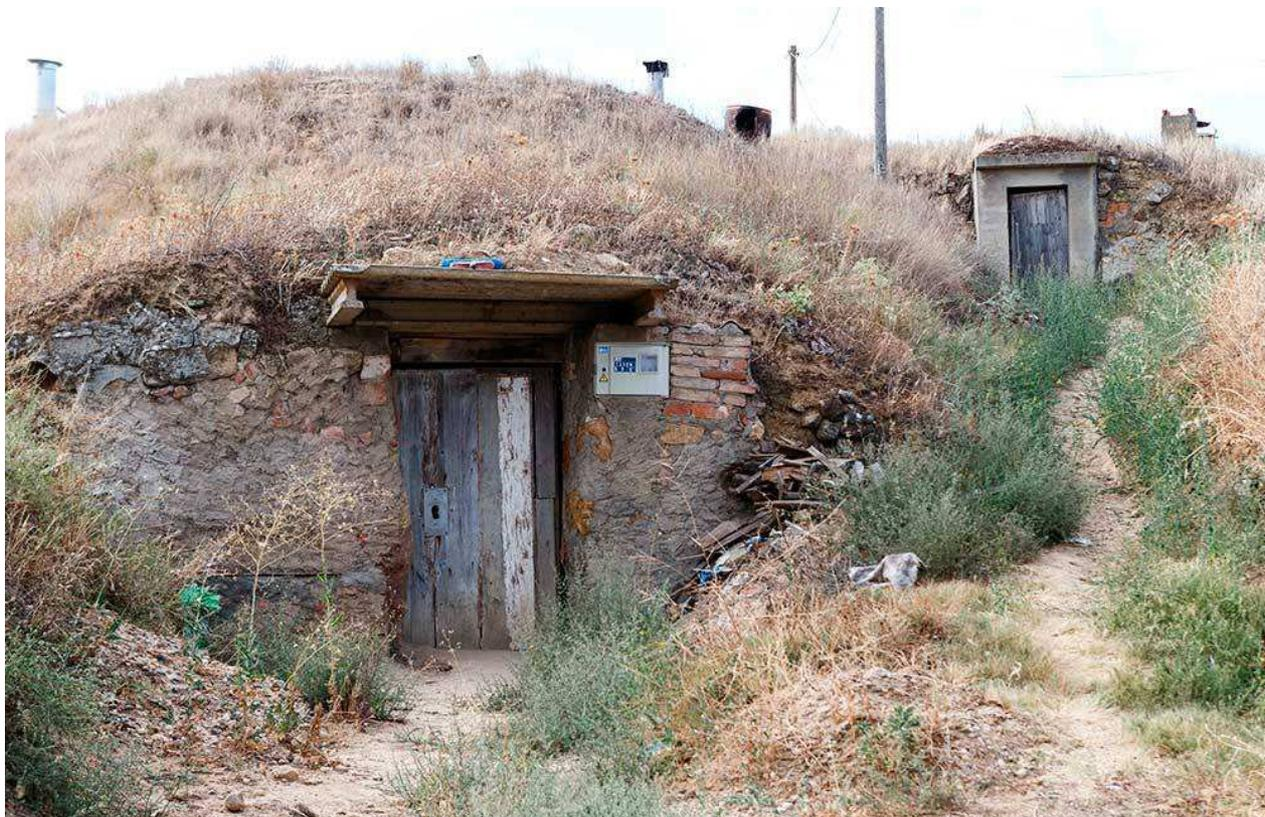
**-Bodegas.** Construidas excavando una galería hacia el subsuelo, en ellas la tierra extraída se acumula encima de la galería para protegerla e impedir las filtraciones. En la galería principal se abren sisas para almacenar las cubas, tinajas y toneles que conservan el vino.
