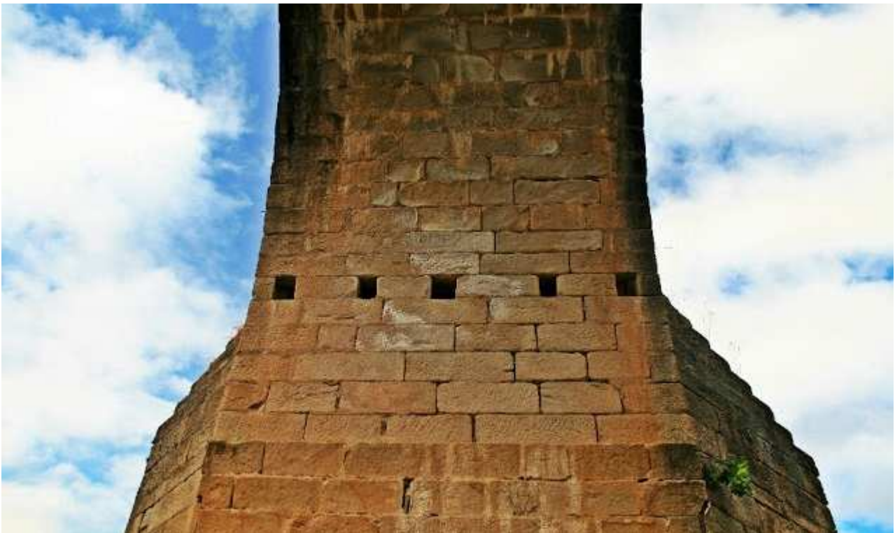
Vista inferior de uno de los arcos del puente. Detalle de los hornillos
