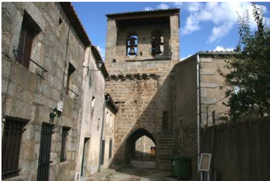
Parte de la Torre de las Campanas cercana al castillo
