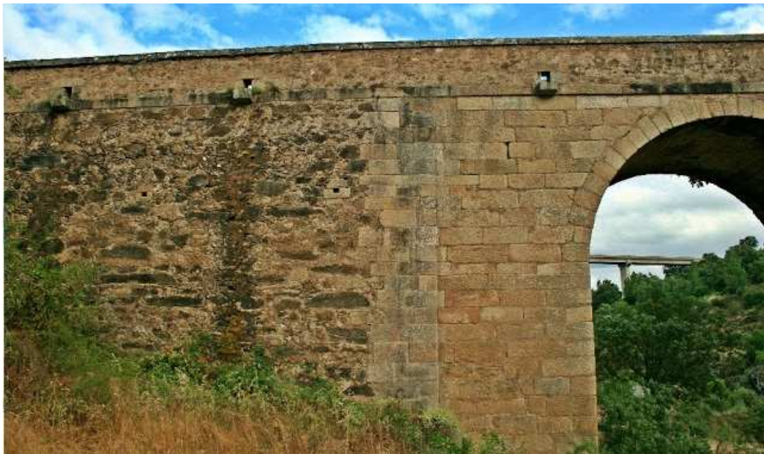
Detalle de la unión del puente y del muro
