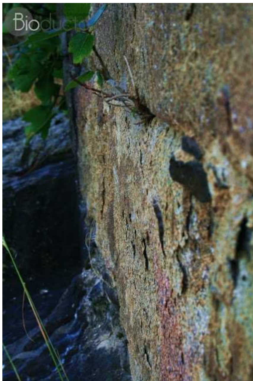
Detalle del estado de la sillería del puente
