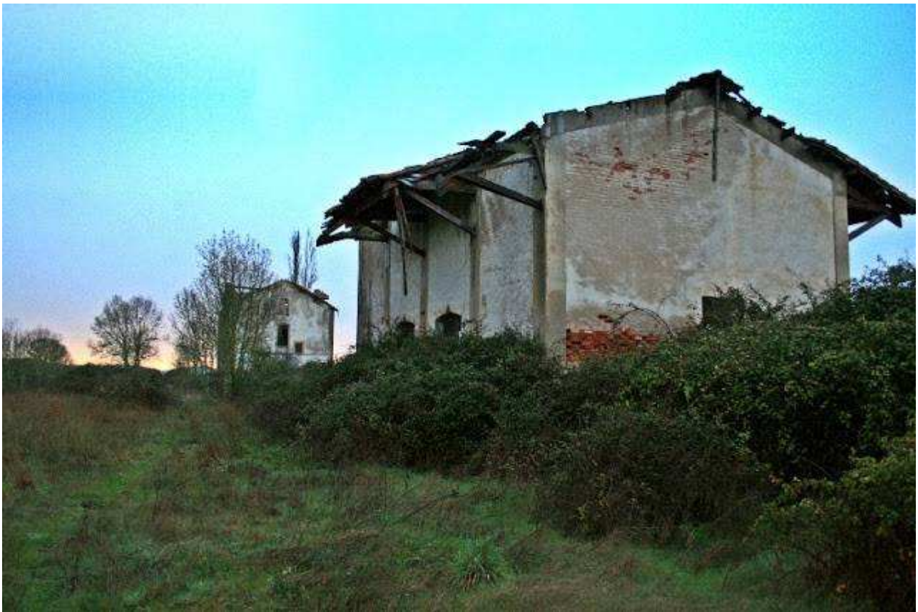
Almacen - muelle de la estación de ferrocarril de Bogajo
