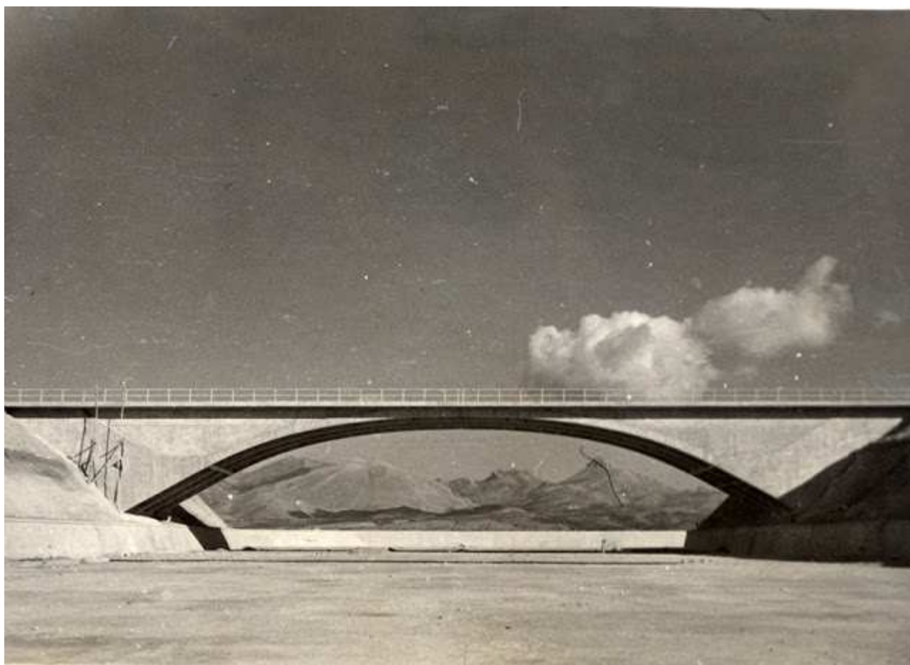
Estado final del puente de Albolote (Granada) - similar al proyectado originalmente
