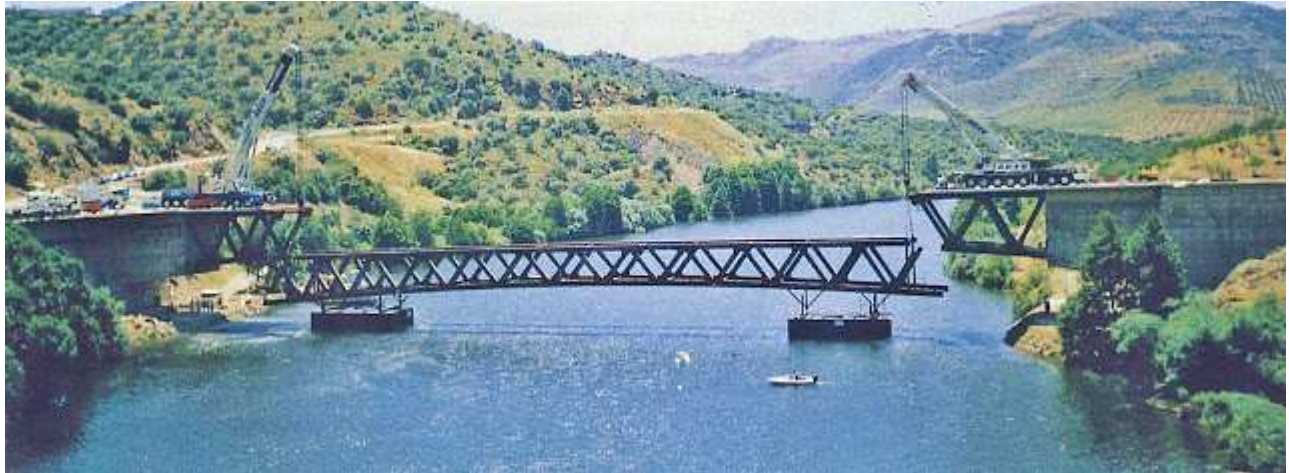
Izado de la estructura mediante dos grúas móviles
