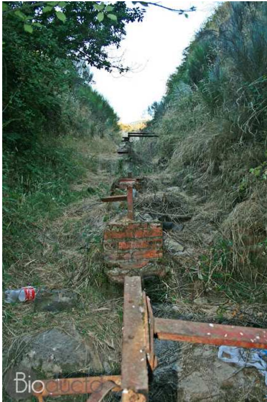
Sistema de elevación de materiales desde la galería
