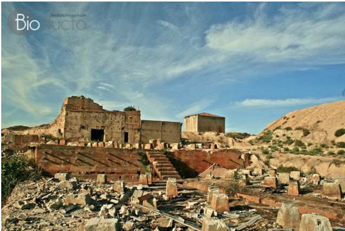
Zona de separación del mineral y el sobrante. Se utilizaban mesas vibratoras, de las cuales solo han resistido sus cimientos
