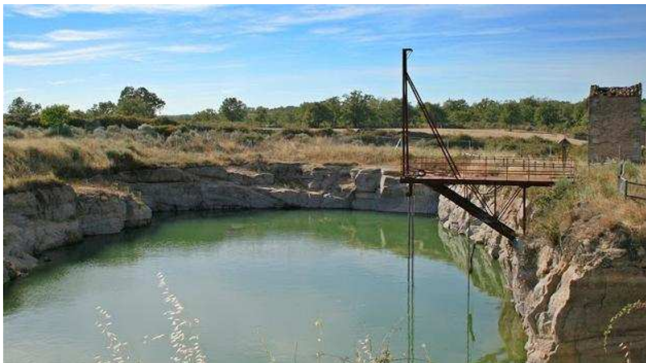
Vista desde el este del socavón de la mina
