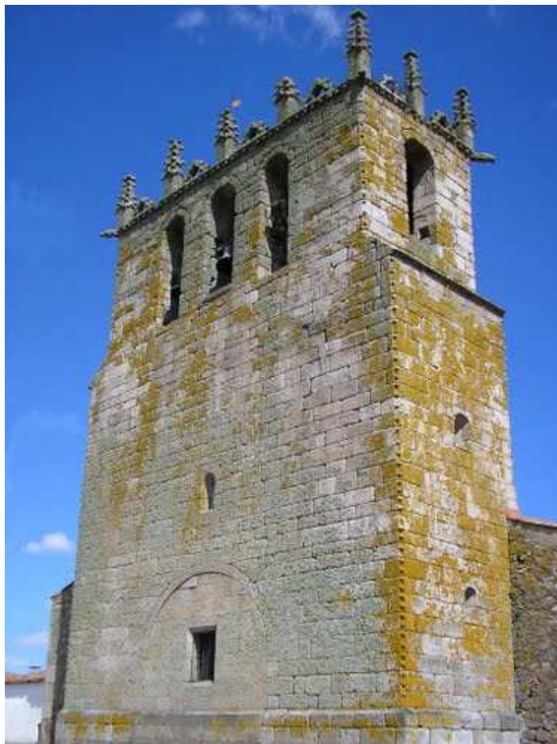
Torre de Guadramiro
